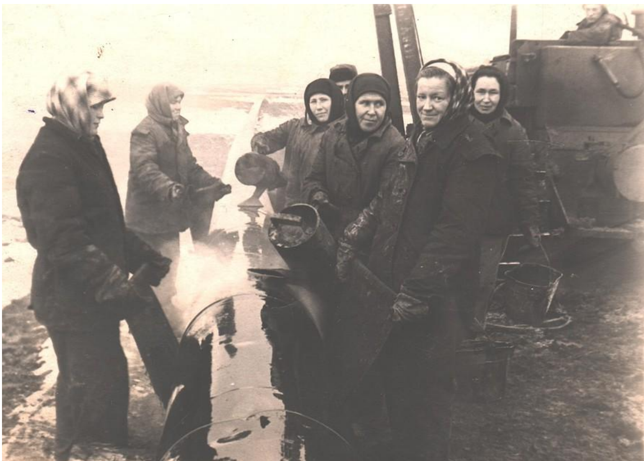
Техники было так мало, что трубопровод прокладывали практически вручную. Фото: администрация г.о. Похвистнево.
